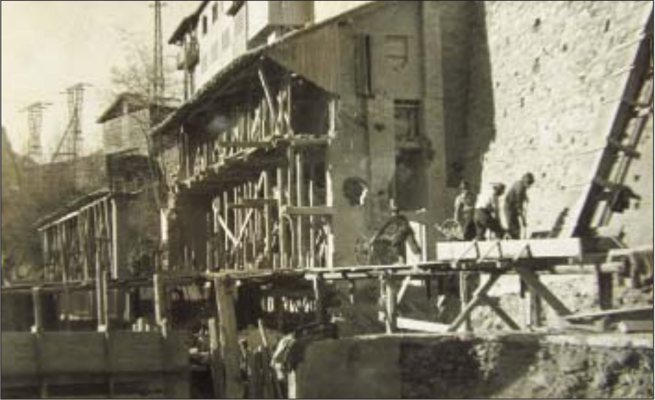
Al centro dell'immagine la parte più antica in ristrutturazione della Cementeria Mazzoleni in una foto della fine degli anni '40 del secolo scorso (collezione privata del sig. Paninforni Carmelo - Burtulù - di S. Giovanni)
