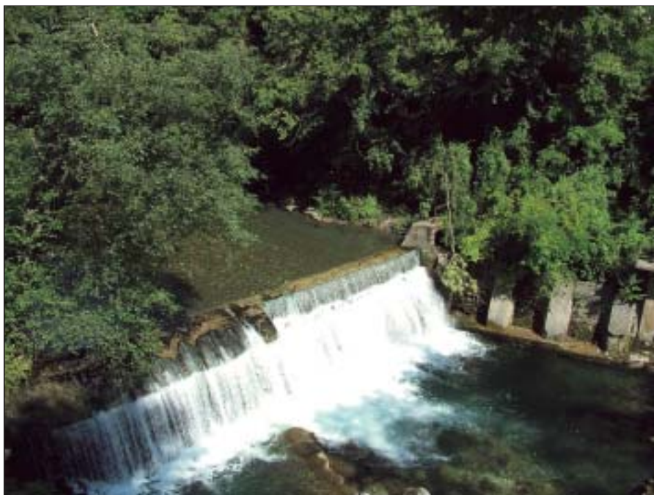
La presa d'acqua sul torrente Enna e l'inizio del canale di derivazione della Cementeria Mazzoleni. L'aspetto attuale delle opere che si vedono in questa immagine deriva da una ristrutturazione del 1955 circa
