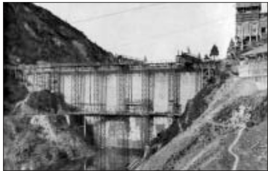
La diga del Pian Casere in costruzione.
