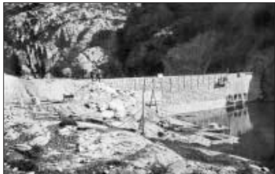
La diga del lago Marcio in costruzione.
