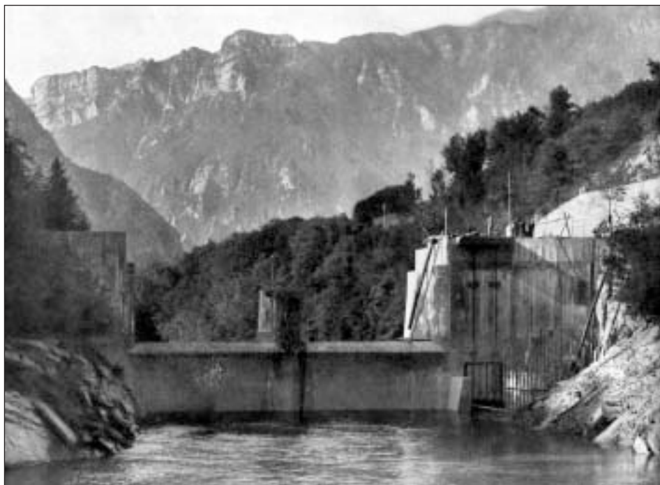
La diga del lago di Moio.
