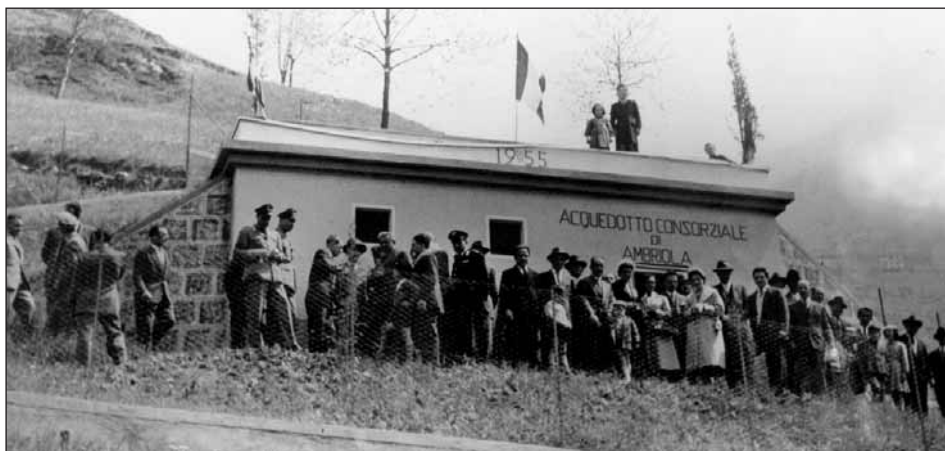
Il serbatoio dell'acquedotto
