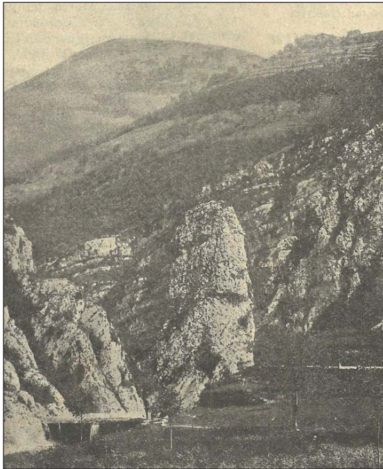
In basso a sinistra si nota lo sbarramento del torrente Brembilla adiacente alla Goggia per convogliare nella roggia l'acqua che azionava le turbine della centrale elettrica
