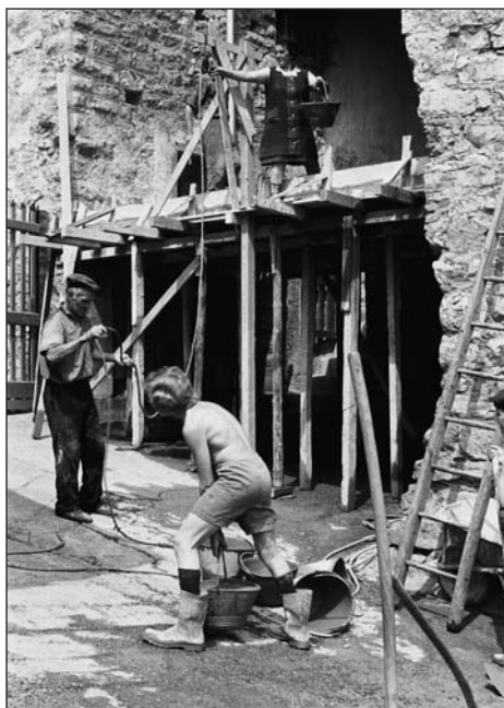
Tre generazioni al lavoro
