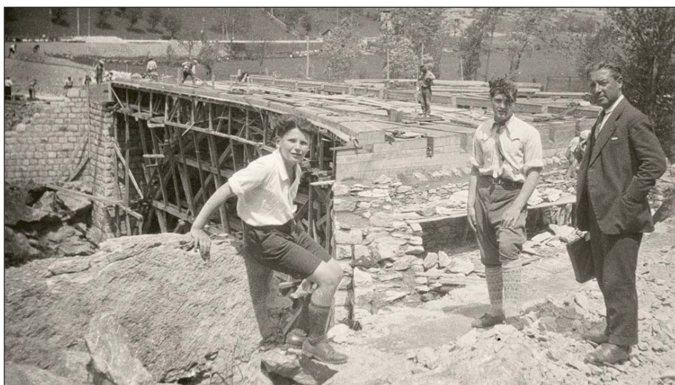
Lavori di la costruzione del ponte di Malonno in Val Camonica. Il ragazzo in primo piano è il figlio Beppe. (Collezione fraterna Calegari)
