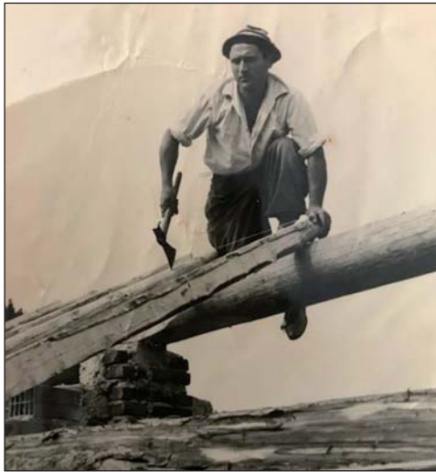
Oltre il Colle, 1953/54 - Un giovane Sergio impegnato nella costruzione della sua prima casa
