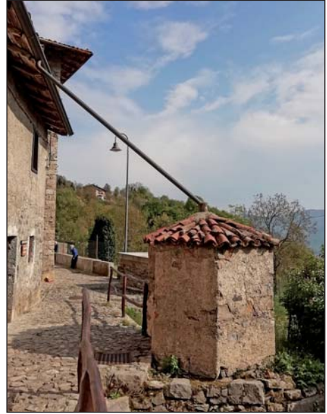
Cisterna con tubatura per la raccolta dell'acqua piovana
