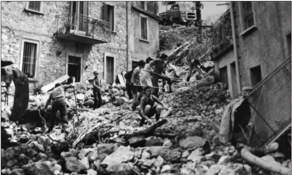
Oltre il Colle, 1974 - Danni causati dall'alluvione del 5 giugno. A sinistra casa Palazzi, a destra casa Fezzoli
