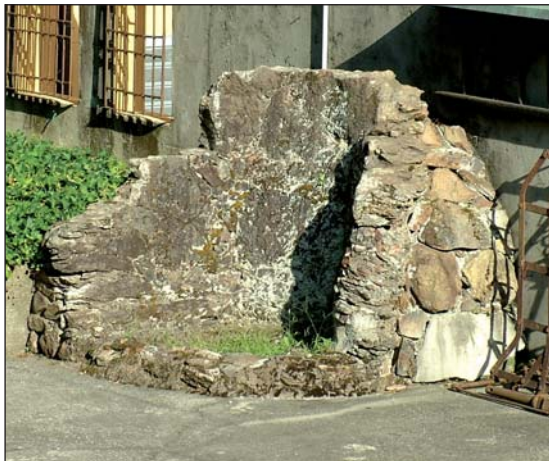
I resti del forno fusorio da ferro ritrovato sul fondo del laghetto di Carona nel 1979 (larg. = cm 250 ca; alt. = cm 150 ca; prof. = cm 120 ca)
